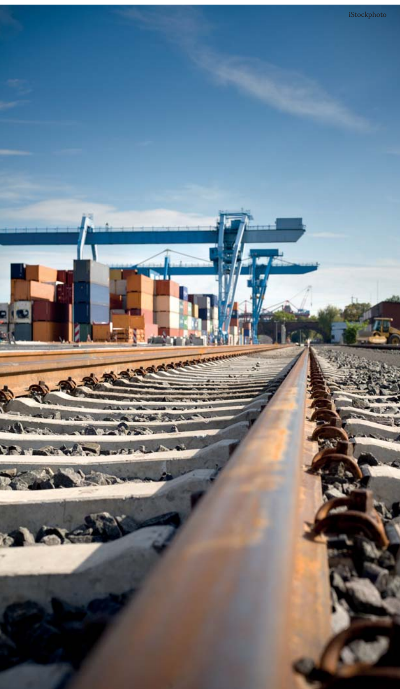
Železničke veze na kontejnerskom terminalu Mainz, Nemačka.
